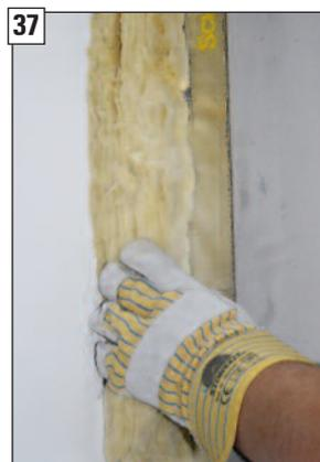
37 Bauseitige Dämmung zwischen der eingebrachten oberen Nutplatte und der Innenwand einbauen.
