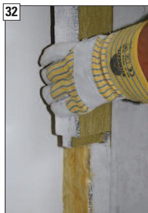
32 Doppelfederplatte in die Nutplatte einstecken.
