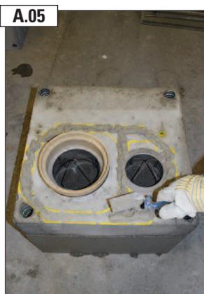
Dünnbettmörtel, innerhalb der Markierungen auf der Übergangsplatte, gem. der ABSOLUT-Versetzanleitung auftragen.
