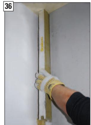
36 Obere Nutplatte in die Doppelfederplatte einstecken.
