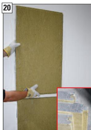
20 Doppelfederplatte in die Nutplatte einstecken und ...
