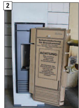
2 Werkseitige Schutzabdeckung entfernen.
