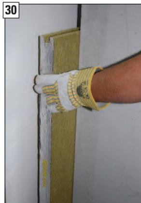
30 Untere Nutplatte des Spezial-KINGFIRE-Rückwanddämmsets hinter die Rückwand der Feuerstätte schieben.
