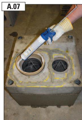
**RAPID-Fugendicht** (7) auf **ABSOLUT-Adapterring** (12) auftragen.
