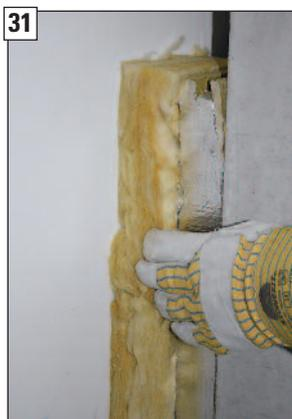
31 Bauseitige Dämmung zwischen der eingebrachten unteren Nutplatte und der Innenwand einbauen.
