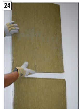
24 Obere Nutplatte in die Doppelfederplatte einstecken.
