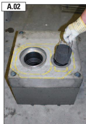
Unteren Schutzschwamm **Zuluft** (2) in Zuluftstutzen einstecken.
