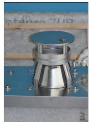
Unterlegscheiben auflegen, Inbusschrauben einstecken und Regenhaube „EAGLE“ mit der Zuluftkopfplatte-Edelstahl verschrauben.
