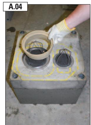
**ABSOLUT-Adapterring** (12) in Montagetrichter einlegen.
