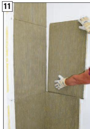
Spezial-KINGFIRE-Rückwanddämmung spaltfrei ansetzen.
