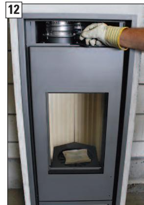
12 Abdeckrahmen bis zur bauseitigen Verkleidung aufschieben und Befestigungsschrauben umlaufend festziehen.
