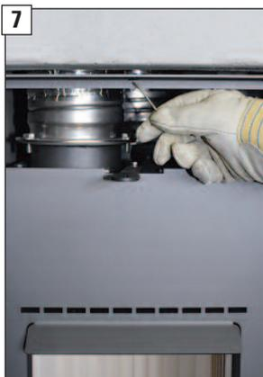
7 Mit Inbusschlüssel alle Befestigungsschrauben am Brennkammerrahmen vollständig zurückschrauben.
