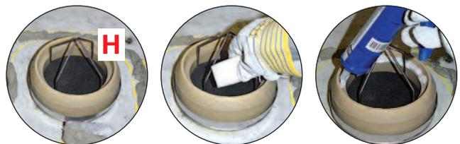
Versetzhilfe (H) einbringen, Muffenverbindung säubern und Klebemörtel RAPID-fugendicht gleichmäßig auftragen.
