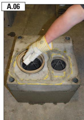
Muffenverbindung gem. der ABSOLUT-Versetzanleitung säubern.
