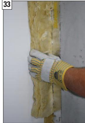
33 Bauseitige Dämmung zwischen der eingebrachten Doppelfederplatte und der Innenwand einbauen.
