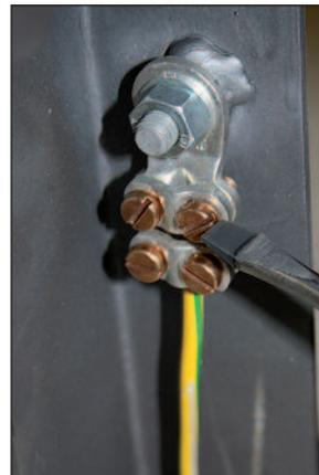
Zum bauseitigen Anschluss kann die im Traglager des KINGFIRE PARAT S werkseitig eingebaute Klemme für den Potentialausgleich (innerer Blitzschutz zur Vermeidung von Überschlüssen und interner Spannungverschleppung) verwendet werden. Es muss mit einem PA-Leiter von mind. 2,5 mm<sup>2</sup> CU (geschützt) oder 4 mm<sup>2</sup> (ungeschützt) angeschlossen werden.
