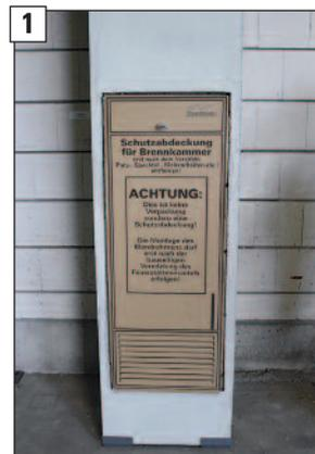
1 Ansicht der werkseitigen Schutzabdeckung nach Beendigung der bauseitigen Veredelungsarbeiten am Feuerstättenmantel.
