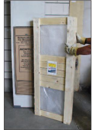
3. Die werkseitige Schutzabdeckung bis zum Abschluss der bauseitigen Veredelungsarbeiten (Putz- und Malerarbeiten) nicht entfernen!
