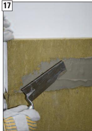
17 Spezial-KINGFIRE-Rückwanddämmung kann wahlweise bauseitig an die Innenwand geklebt oder ...
